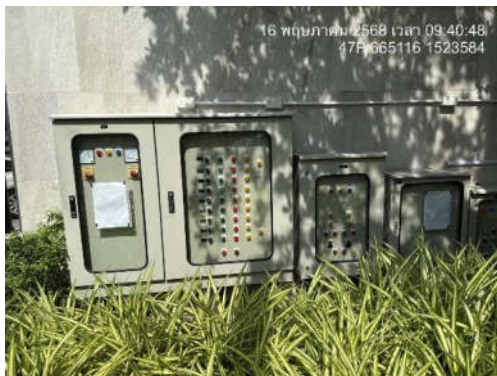
รูปที่ 8 มิเตอร์ระบบบำบัดน้ำเสีย
