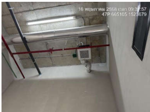
รูปที่ 15 พัฒนาดูดอากาศภายในห้องพักขยะเปียก
