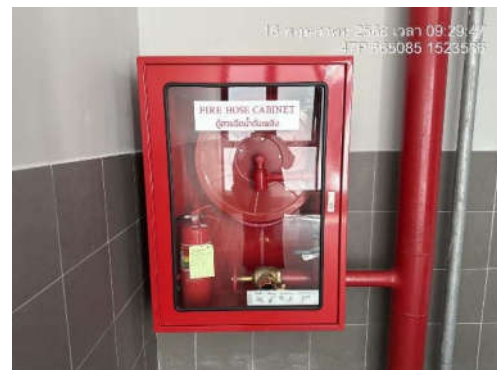
รูปที่ 28 ตู้ดับเพลิง Fire Hose Cabinet (FHC)
