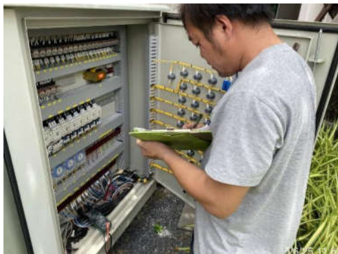
รูปที่ 52 เจ้าหน้าที่ตรวจสอบตู้ควบคุมระบบบำบัดน้ำเสีย
