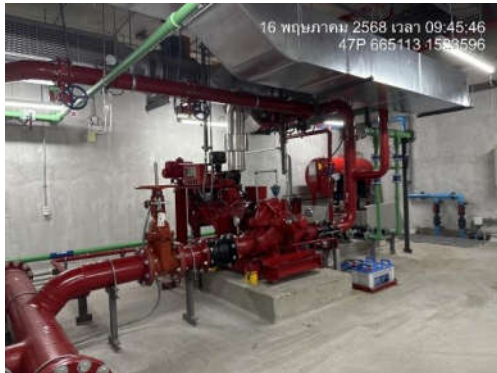
รูปที่ 7 ห้องสำรองน้ำดับเพลิง
